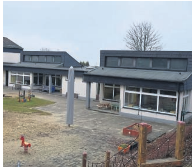
Der alte Kindergarten in Wiblingwerde ist stark renovierungsbedürftig und soll weichen. FOTOS: SCHMITZ-MACHELETT
