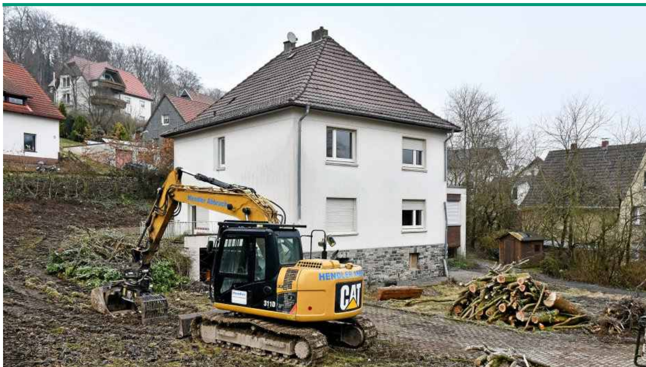
Das Pfarrhaus der evangelischen Kirchengemeinde Ihmert wird abgerissen und durch Wohnhäuser für Familien ersetzt. Foto: Ralf Engel / Iserlohner Kreisanzeiger und Zeitung
